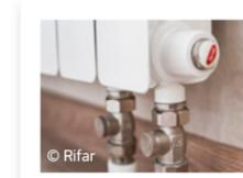
↑ Специальное исполнение Ventil радиаторов Rifar имеет нижнее подключение и встроенную систему управления температурой
